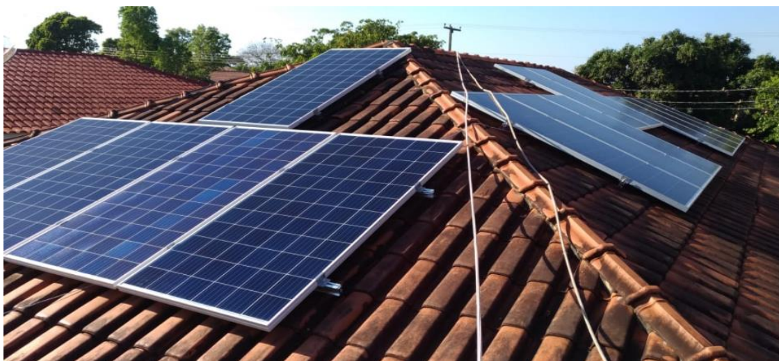
FIGURA 27– DISPOSIÇÃO DOS PAINÉIS FOTOVOLTAICOS DA INSTALAÇÃO
