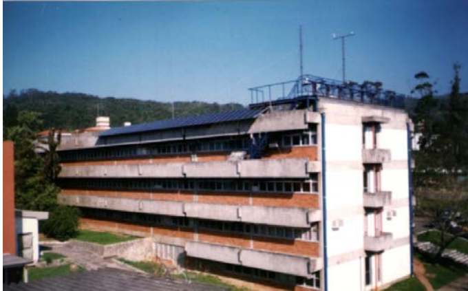
Figura 18: Vista do sistema solar fotovoltaico integrado ao envoltório da edificação do Departamento de Engenharia Mecânica da Universidade Federal de Santa Catarina em Florianópolis, SC.
