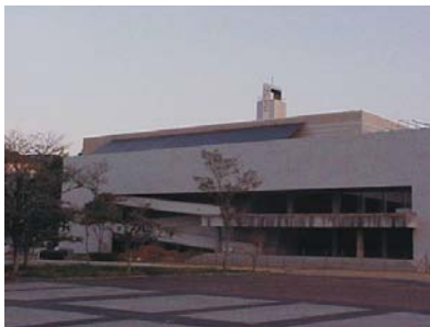
Figuras 24: Centro de Eventos da UFSC, com sistema fotovoltaico de 10kWp integrado a parte da cobertura da edificação.
