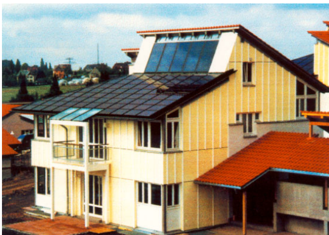
Figura 32: M dulos solares de filmes finos de sil cio amorfo (a-Si) nesta resid ncia multifamiliar substituem toda uma se  o do telhado, com apar ncia est tica agrad vel e reduzindo os custos associados ao telhado que substituem [Phototronics Solartechnik GmbH].
