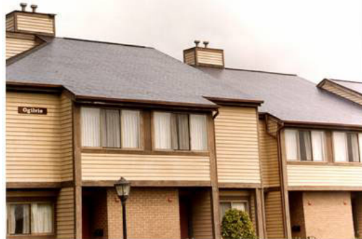
Figura 39: Exemplos de m  dulos solares fotovoltaicos flex  veis de a-Si configurados sob a forma de shingles (que podem ser pregados diretamente sobre um telhado de madeira), ou sob a forma de rolos autocolantes (que podem ser colados diretamente sobre telhas met  licas) [United Solar Ovonic LLC].
