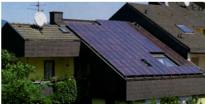
Figura 31: Sistema fotovoltaico instalado em retrofit sobre telhado de resid ncia unifamiliar, utilizando m dulos solares de sil cio amorfo (a-Si) [Fraunhofer Institut f r Solare Energiesysteme, 1000 Roofs Program].
