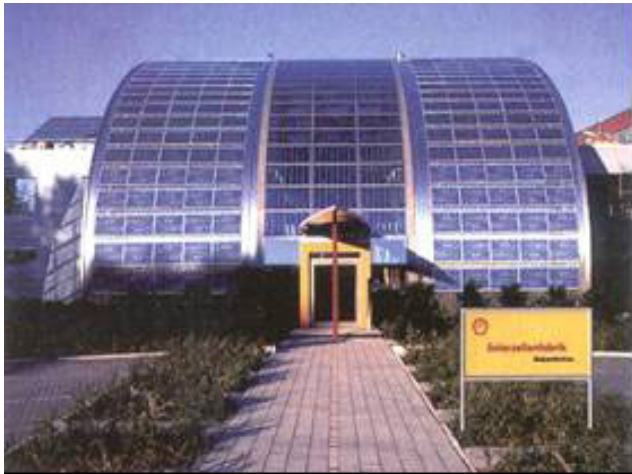
Figura 44: Edifício solar fotovoltaico industrial que abriga uma fábrica de células solares fotovoltaicas, utilizando módulos planos de p-Si compondo uma fachada curva [Shell Solar GmbH].
