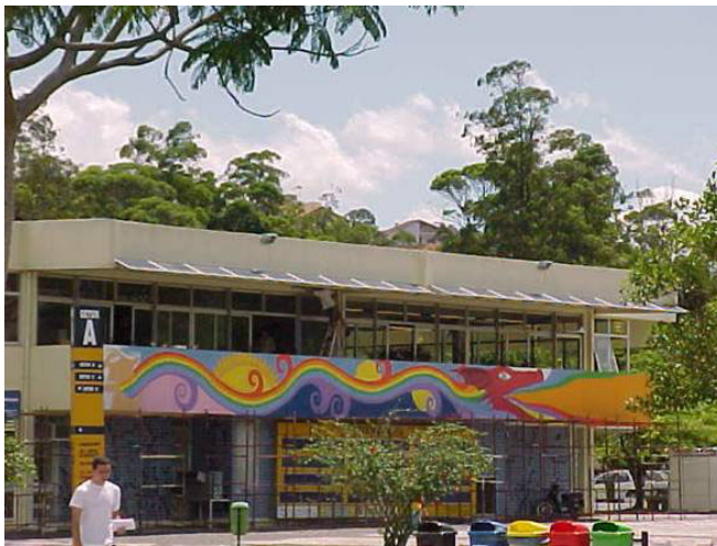
Figura 22: O conjunto de módulos fotovoltaicos totalizando 1.15kWp está integrado à fachada norte do Centro de Convivência no campus central da UFSC em Florianópolis – SC. Em primeiro plano aparecem as diversas lixeiras do programa de lixo seletivo da universidade.
