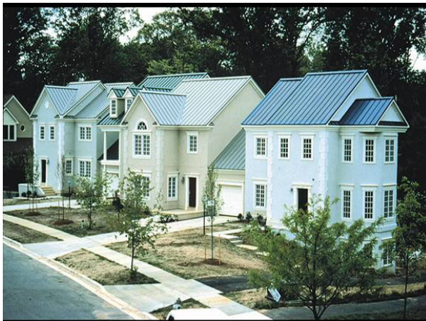
Figura 35: A integração de módulos solares fotovoltaicos de filmes finos de a-Si colados diretamente sobre telhas metálicas pode ser discreta como ilustra esta figura, onde somente a residência da extrema direita recebeu a integração dos elementos fotovoltaicos ao seu telhado [United Solar Ovinic LLC].
