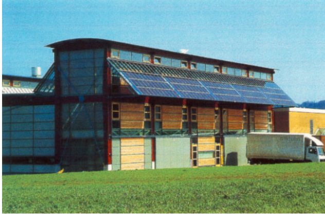
Figura 43: Utilização de módulos solares fotovoltaicos de filmes finos de silício amorfo (a-Si) integrados a uma edificação industrial [Phototronics Solartechnik GmbH].
