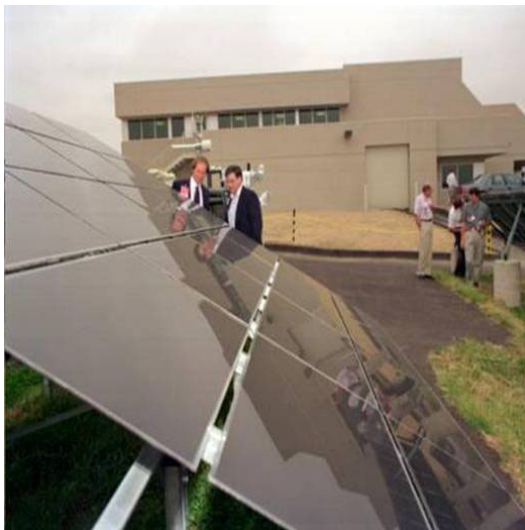
Figura 9: Exemplo de módulos solares fotovoltaicos de CdTe em substrato de vidro para aplicações arquitetônicas [National Renewable Energy Laboratory].
